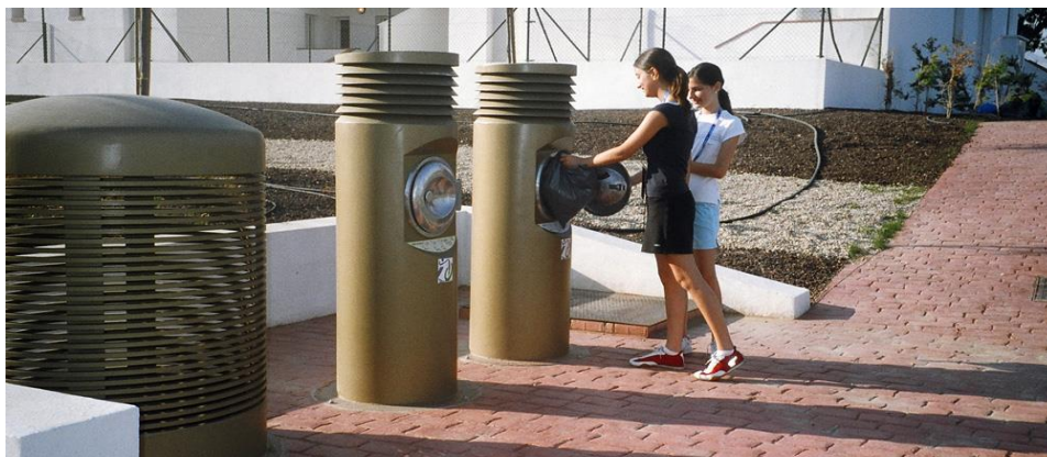
Illustrasjon 5: Innkast for avfallssug i El Toyo i Spania.
