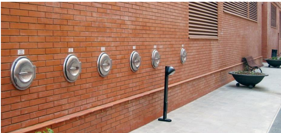
Illustrasjon 3: Eksempel fra Spania hvor innkast til avfallssuganlegg er plassert i vegg.
