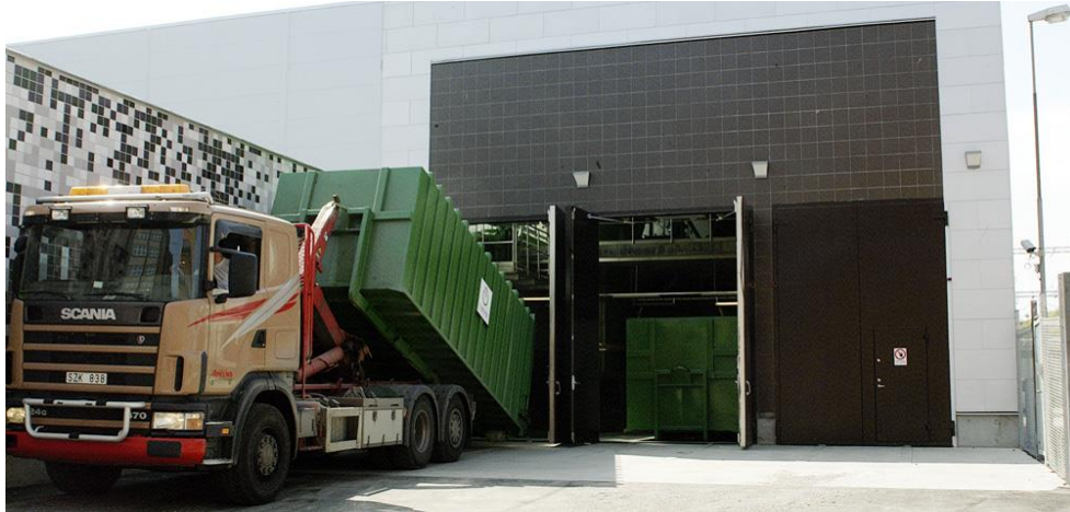
Illustrasjon 6: Eksempel 1 på en avfallssugterminal med containere for kildesortert avfall.
