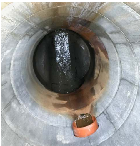
Eksisterende overvannskum nr. 60237 i Peder Østlunds veg. Påkoblingspunkt for første fase. Brøsetbekken lagt i rør. Kum må saneres ved påkobling.
