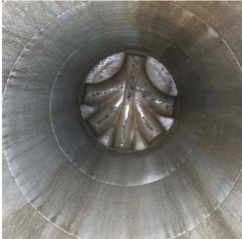
Eksisterende spillvannskum 60243 i Peder Østlunds veg. Påkoblingspunkt for første fase. Ingen spillvann observert, mange ledige løp.
