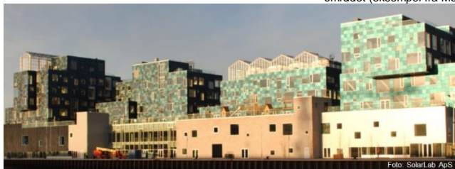
Planlegg for (fasadeintegreerte) solceller. Optimaliser takflater og fasadeareal mot sør. Foto: SolarLab ApS
